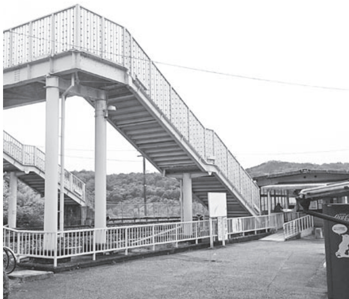
高齢者には渡りにくい高架橋（月ヶ瀬口駅）
