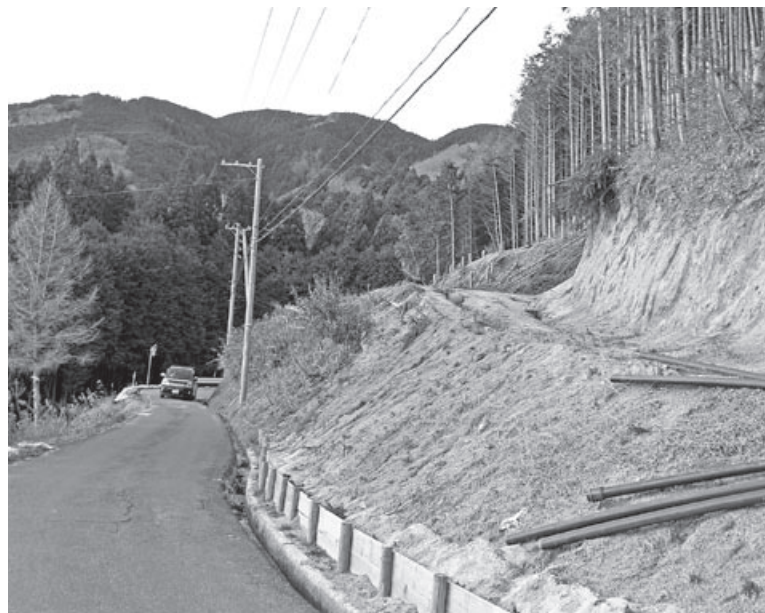
豪雨による土砂崩れの危険がある（大河原多羅尾線）
