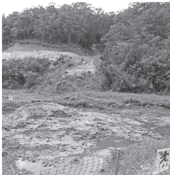
メガソーラー工事現場（押原）
