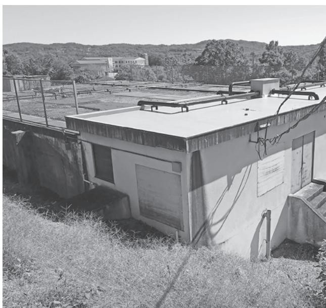
45年経過した合併浄化槽施設（NT）
