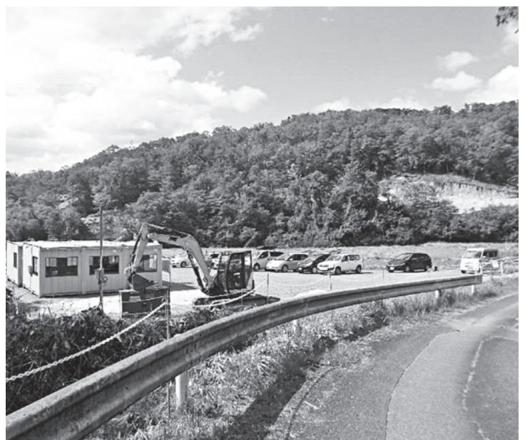
工事着工した開発現場（押原地区）
