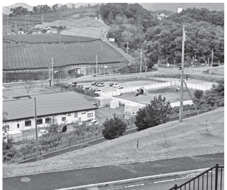
工事が始まった道の駅ホテル
