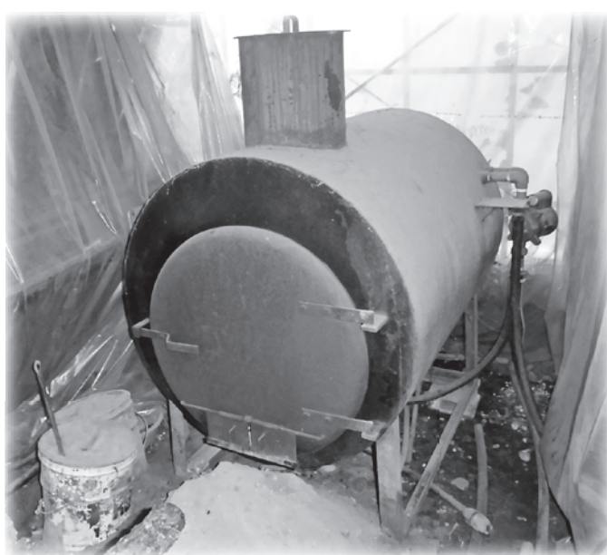
老朽化した原木椎茸暖房の施設
