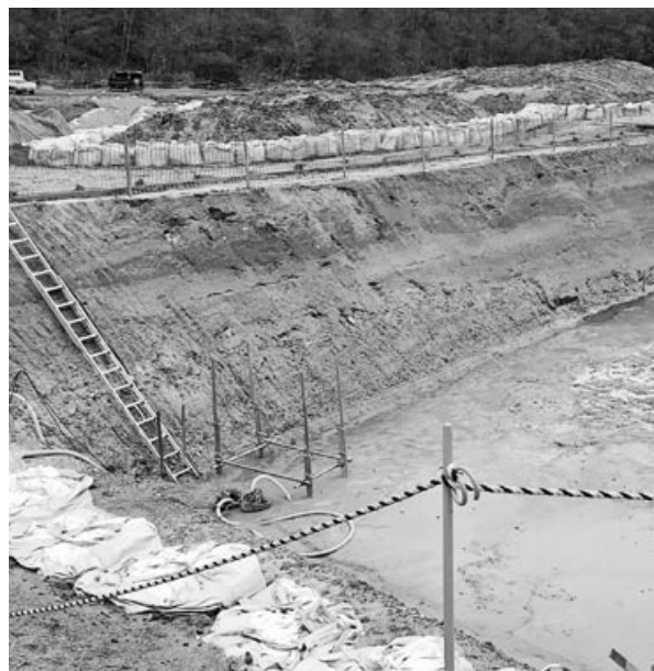
メガ開発地の沈砂池土石流痕
