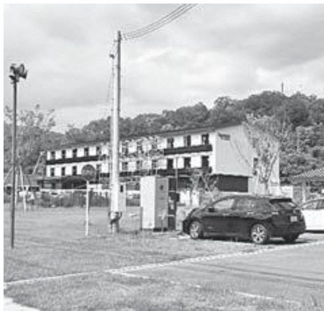
工事完成間近の「道の駅ホテル」
