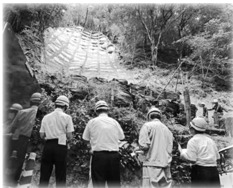
大河原東和束線道路改良工事
