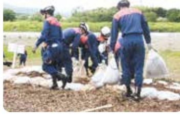
積土のう工法
