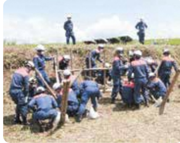
杭打ち積土のう工法
