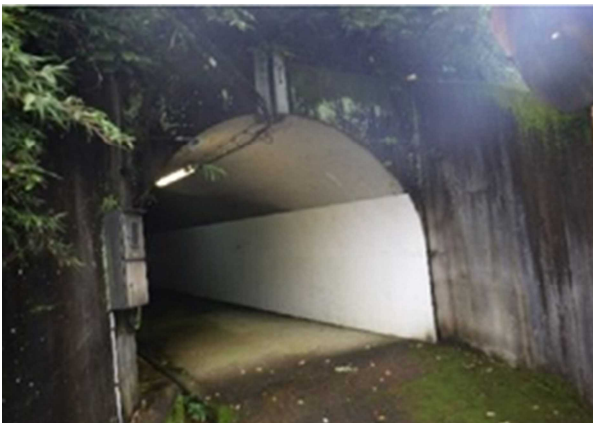
写真2. 3 渋久川隧道(歩道)起点側坑口
