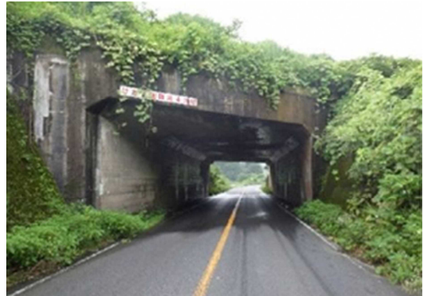
写真2. 2 渋久川隧道終点側坑口
