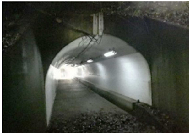
写真2. 4 渋久川隧道(歩道)終点側坑口
