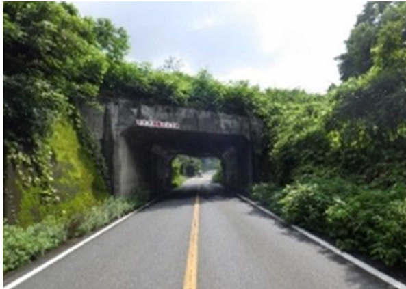
写真2. 1 渋久川隧道起点側坑口
