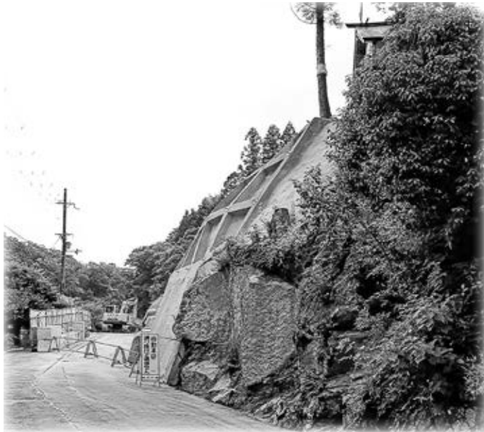
旧国道163号法面工事（今山）
