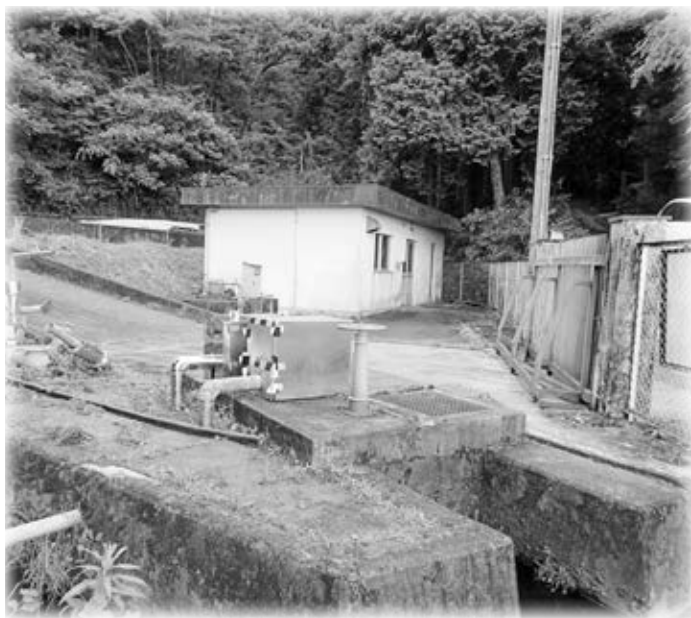
高尾簡易水道施設
