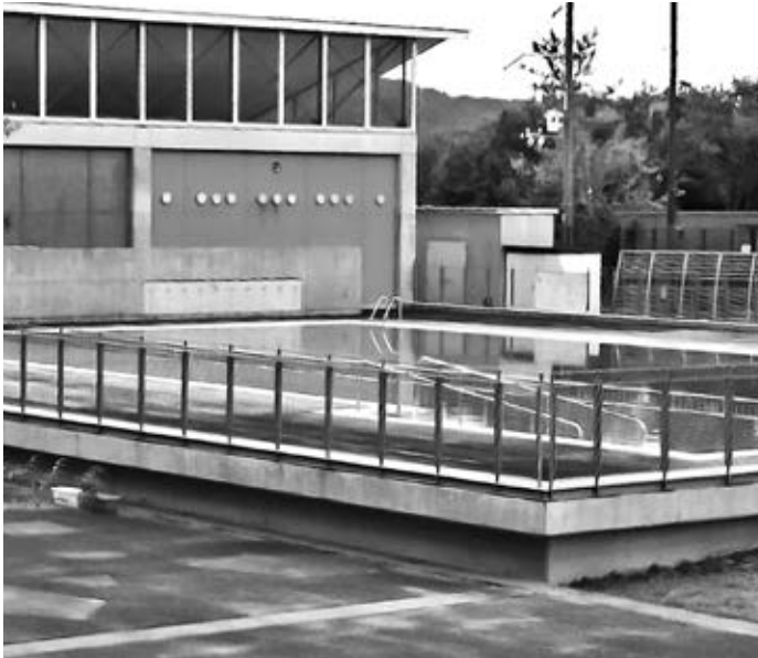
災害時、プールの水が飲料水に（南山城小学校）
