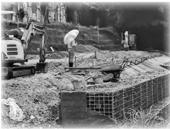
クリーンセンターの法面改修 (和東)
