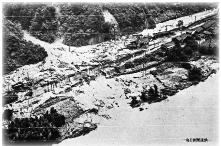
土砂にうずもれた大河原駅(毎日新聞提供) 天王寺鉄道管理局発行「28年災害記録写真編」より
