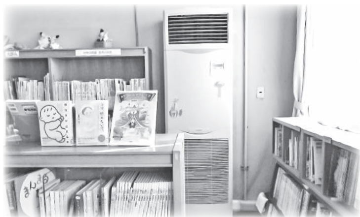
エアコンをもう1台設置(村図書室)
