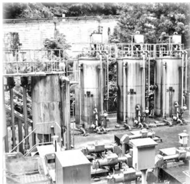
山城谷浄水場の修繕 (本郷)
