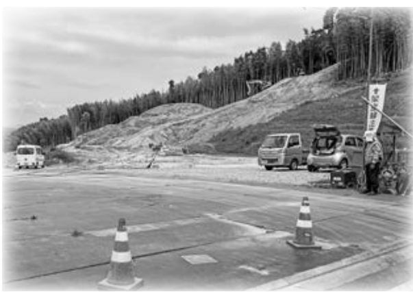
造成工事始まる（中部消防本部）
