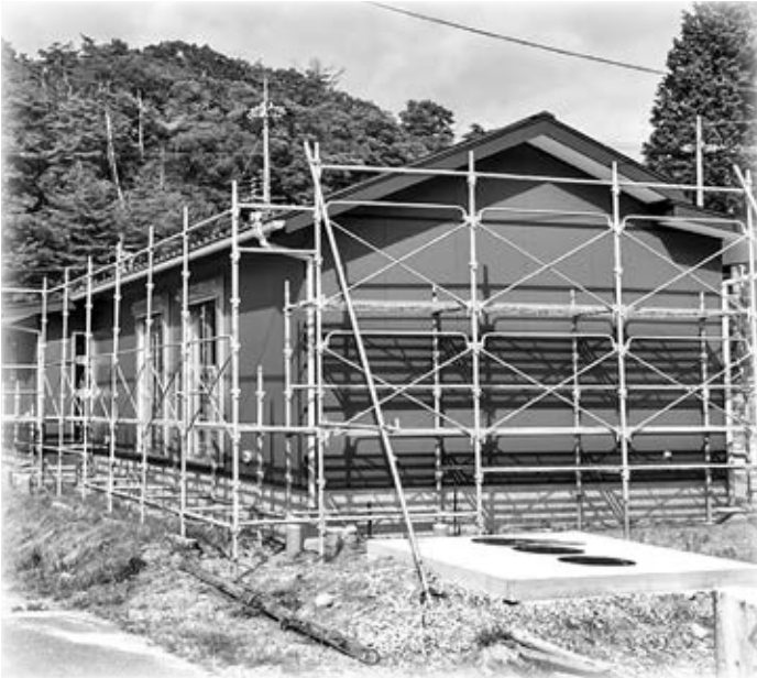
建築中の童仙房公民館
