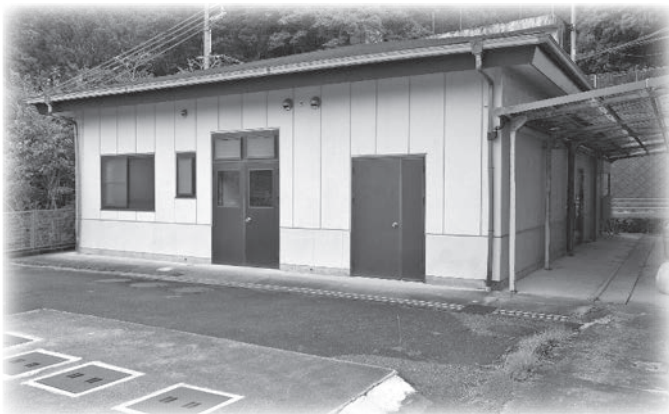
笠置小学校給食室改修工事
