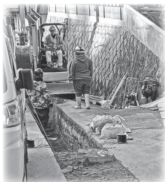
老朽管取り替え工事（高尾）
