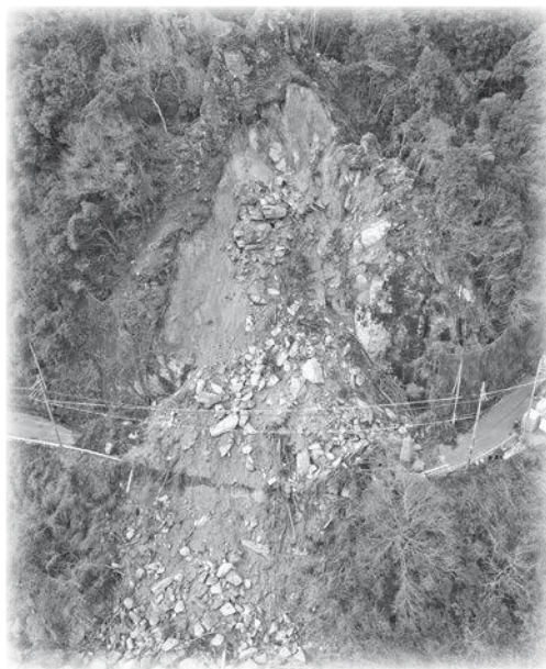
災害復旧中のダムサイド(上野南山城線)
