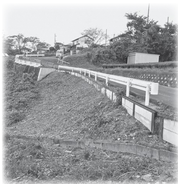
拡張が始まる月ヶ瀬団地殿田平尾線（今山）
