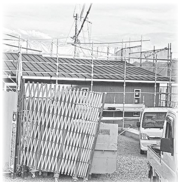
工事中の月ヶ瀬口駅前整備事業
