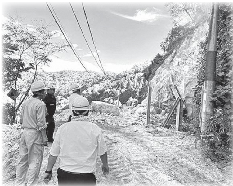
府道上野・南山城線災害復旧工事現場視察
