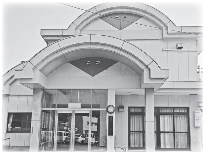
改修される本郷コミュニティセンター
