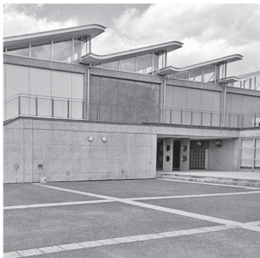
体育館に空調設備を（南山城小学校）
