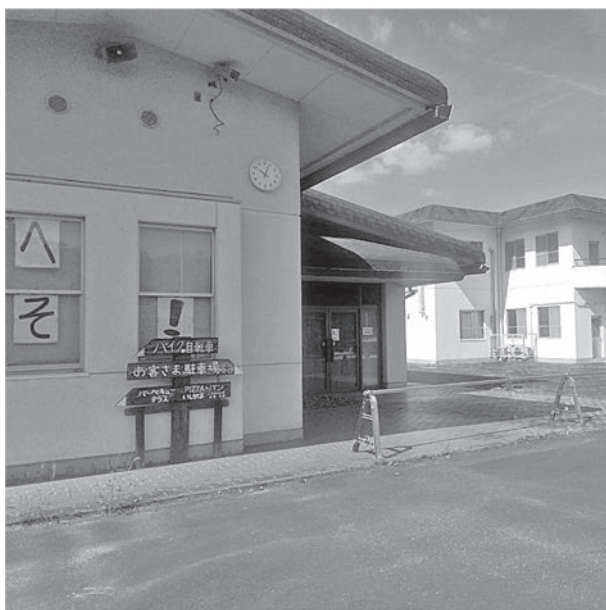
境界が確定していない村有地（旧自然の家 田山）
