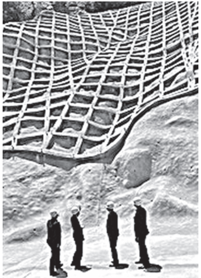
上野南山城線復旧工事完了の視察
