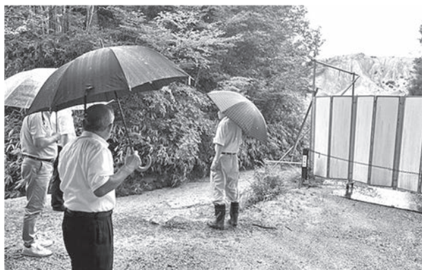
野殿地区の無断開発現場
