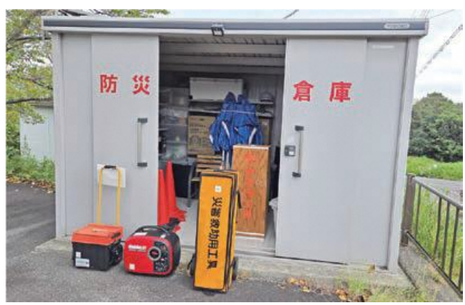
NT設置の防災倉庫
