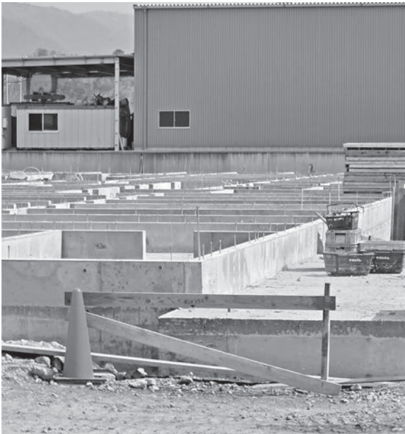
基礎工事が始まった特養ホーム
