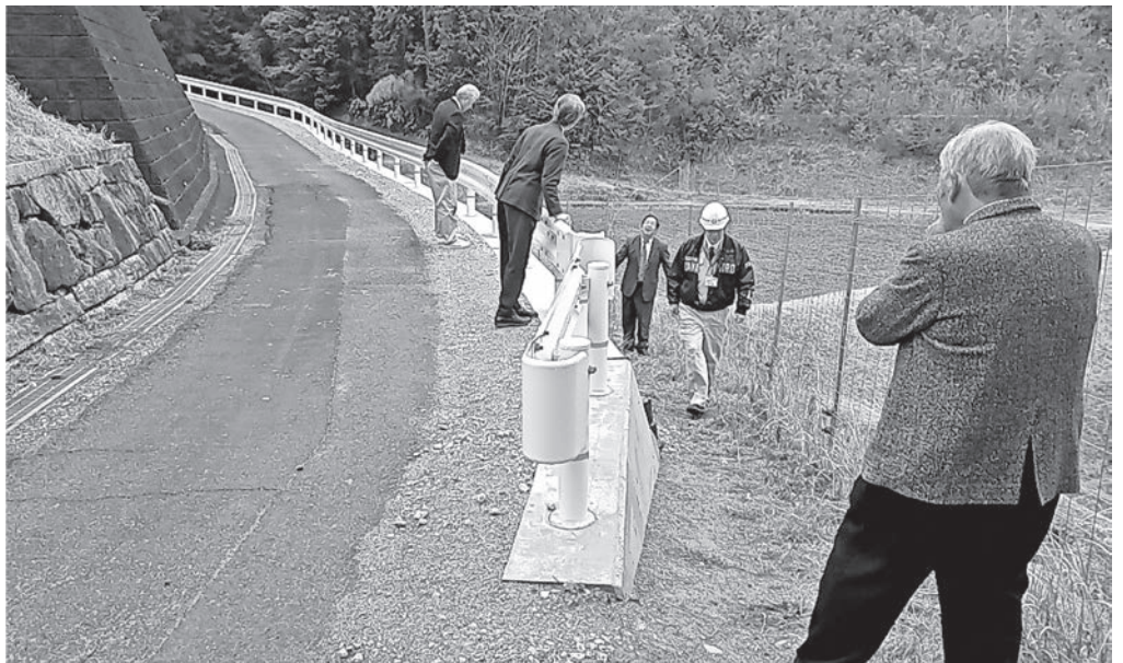
テラセル工法で施工（田山）
