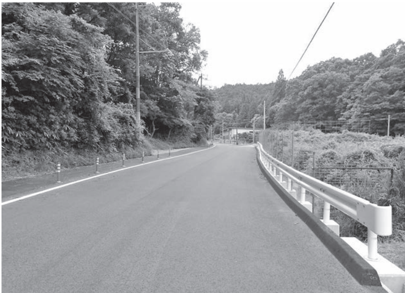
特別交付金で整備された道路（童仙房）
