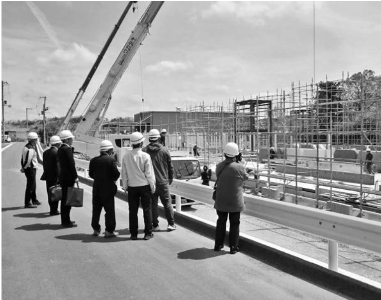
特養ホーム建設現場（今山）
