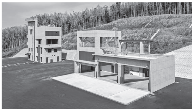
新たに建設された消防本部訓練棟・車庫棟
